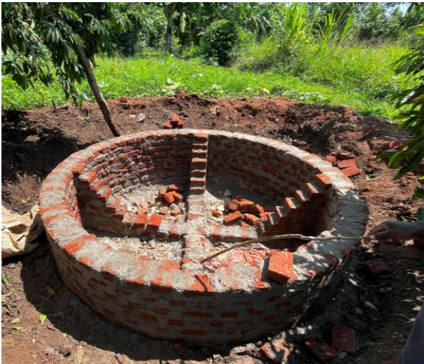
Baufortschritt bei den neuen Wassertanks für die St. Josephs Fram
